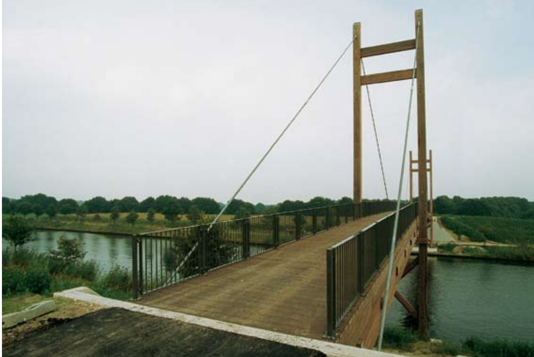
Fiets-, wandel- en ecobrug over Twentekanaal
